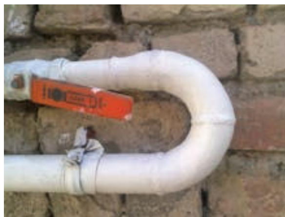
شکل ۸۲-۴ ب بعد از کنتور لوله از \frac{1}{4} به \frac{1}{2} تبدیل شده است
