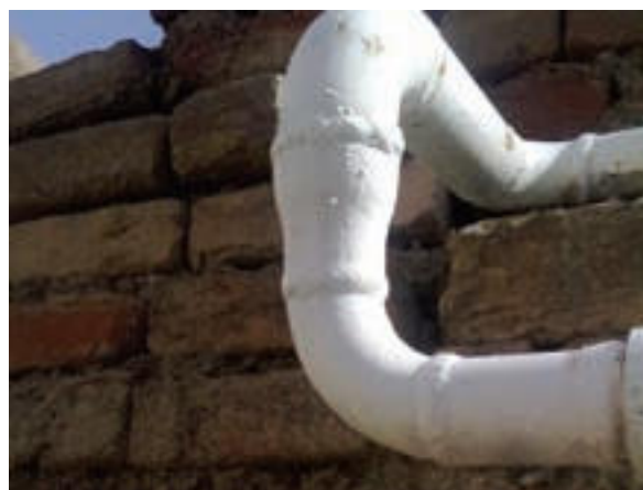
شکل ۸۲-۴ الف قبل از ورود به کنتور لوله از \frac{1}{4} به \frac{1}{2} تبدیل شده است
